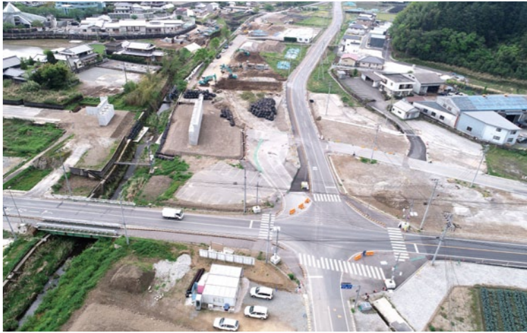
平成31年4月ごろの現場の様子。
